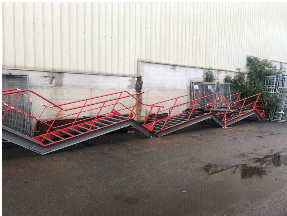
Escaliers en acier déconstruits et stockés en vue d'un nouvel usage - © Général Métal Édition
